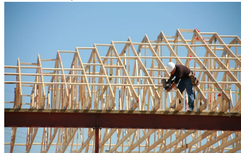
Figura 37: Estrutura em madeira
