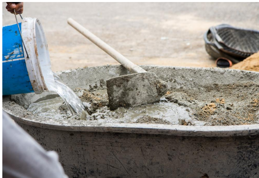
Figura 42: Concreto feito manualmente
