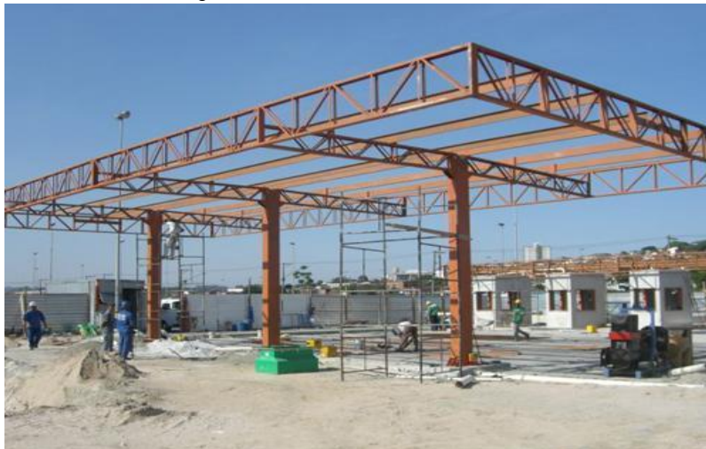
Figura 36: Estrutura em aço
