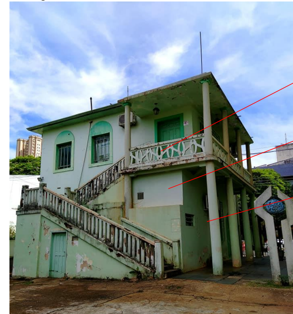
Figura 40: Vista da fachada norte
