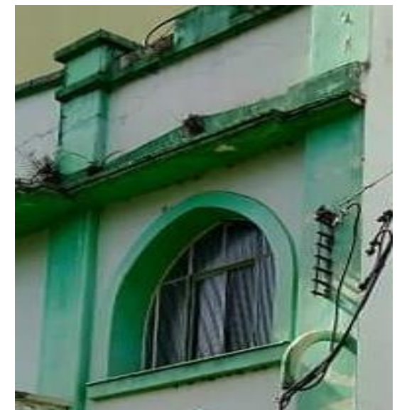
Figura 15: Janela com arco ogival
