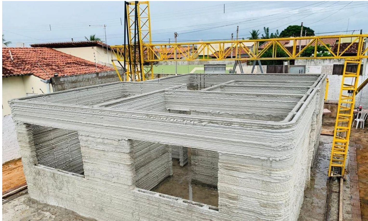
Figura 36: Construção com impressão 3D
