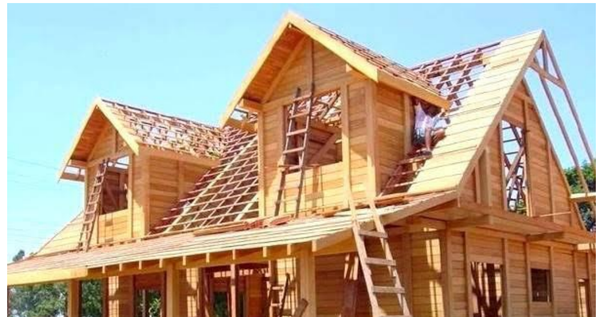
Figura 22: construção em steel wood
