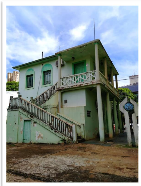
Figura 2: Fachada Norte do edifício Casarão da Quintino
